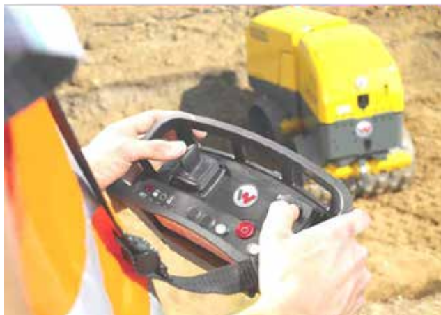
Рис. 2. Ущільнення ґрунту мінікотками
