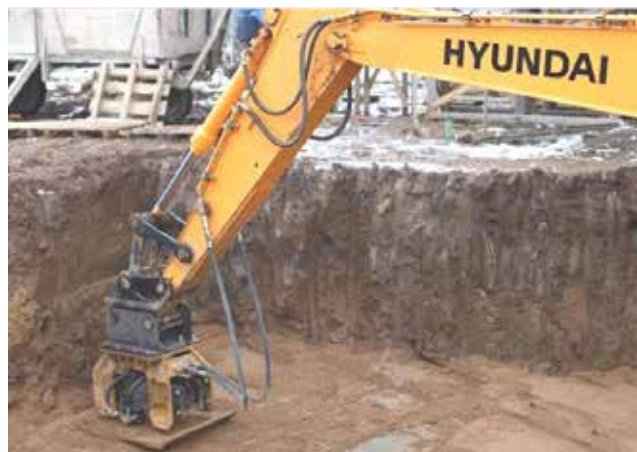
Рис. 3. Ущільнення ґрунту навесними гідротрамбівками
